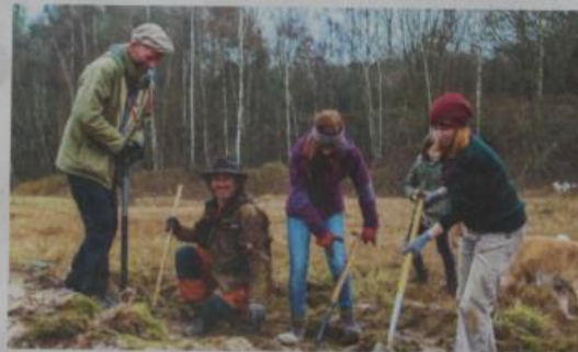
Auch für die anstrengenden Arbeiten zur Anlage von Gräben und Tümpeln fanden sich schnell etliche Helfer.
